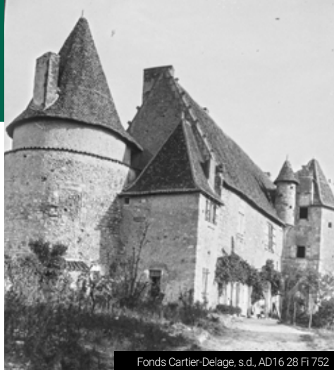
Fonds Cartier-Delage, s.d., AD16 28 Fi 752
